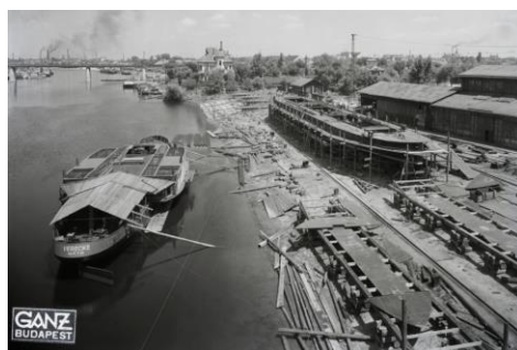
Újpesti-öböl, Ganz és Tsa. Villamossági-, Gép-, Waggon- és Hajógyár Rt. Az MFTR Verecke (1939) oldalkerekes gőzhajó építése. forrás: Fortepan
