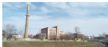
A tömb beépítése Rákospatak t. irányából forrás: saját fotók
